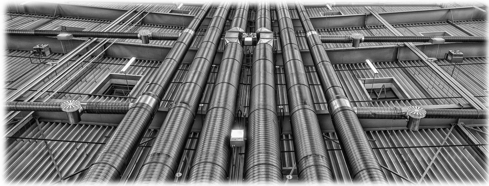
La perméabilité à l'air d'un réseau de ventilation caractérise la quantité d'air qui entre ou sort de manière non contrôlée à travers les parois des gaines de ventilation du réseau. Elle ne caractérise pas les fuites d'air dues aux autres éléments du système de ventilation (caisson du ventilateur, échangeur de chaleur...). Elle se quantifie par la valeur du débit de fuite traversant les parois des gaines, sous un écart de pression donné.
